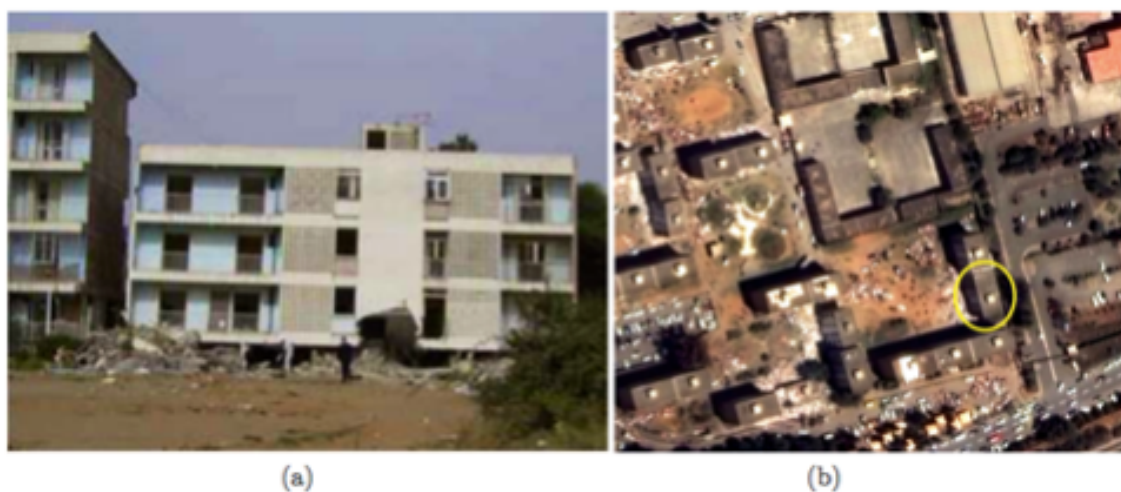
FIGURE 3.18 – Bâtiment à Bourmerdes (Algerie) effondré sur ces deux premiers étages après le séisme de 2003, détectable en vue de face (a) et non détectable en vue satellite (b).
