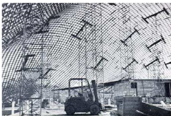
Figure 15 : Photographie du chantier de construction du gridshell de Mannheim
