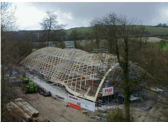
Figure 17 : Photographie du gridshell de Downland en construction [10]
