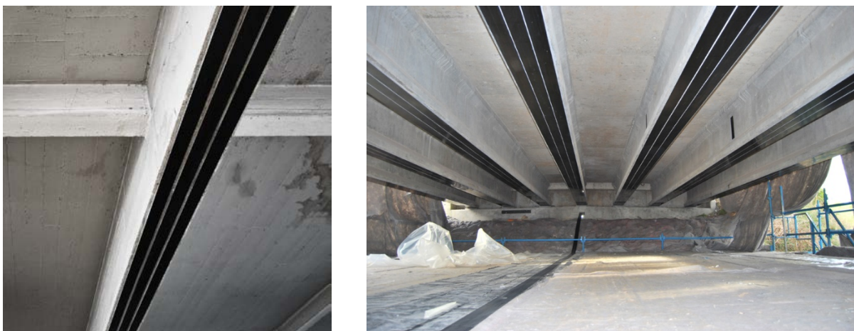
Figure 9. – Photos de mise en œuvre de plats carbone en renforcement de poutres.
