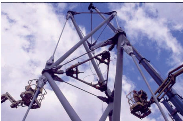
Fig. 26 : Construction de la Tour de Rostock avec un cadre de mise en tension temporaire. 3
