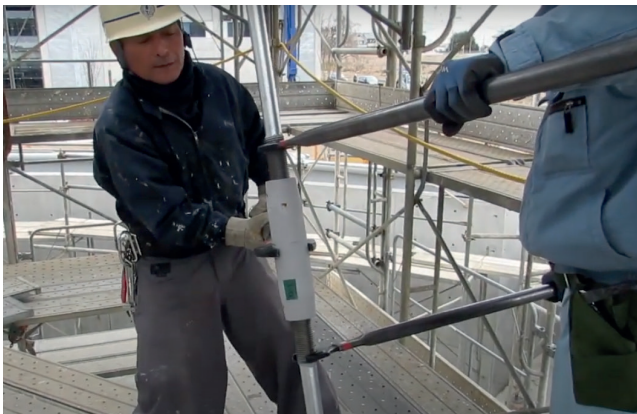
Fig. 28 : Mise en tension manuelle 1
