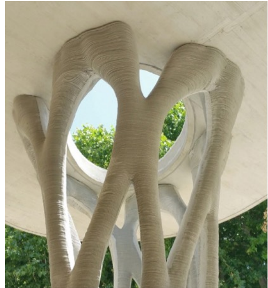
Image 64. Photo d'une colonne réalisée et optimisée topologiquement par XtreeE
