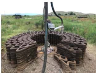
Image 17. Regroupement de photographies des huttes imprimées par Emerging Objects
