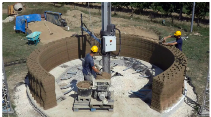
Image 15. Impression à l'aide du contour crafting
