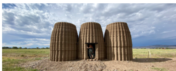
Image 17. Regroupement de photographies des huttes imprimées par Emerging Objects
