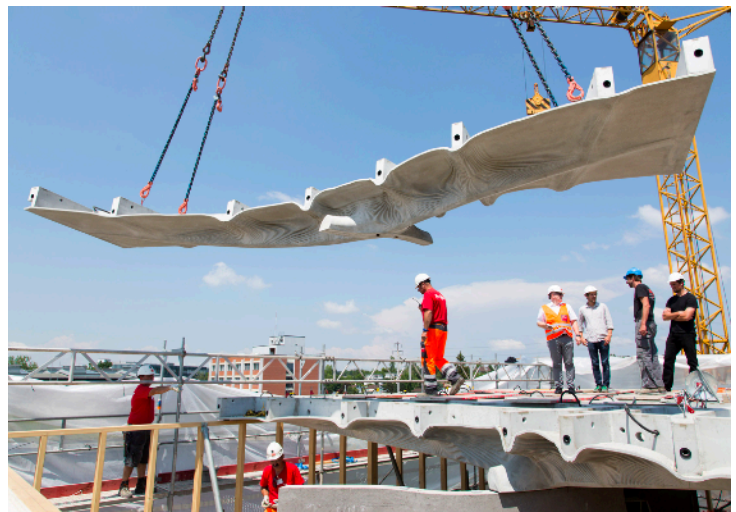
Image 19. Photo de la pose de la dalle en béton imprimé en 3D "The Smart Slab" par ETH Zurich
