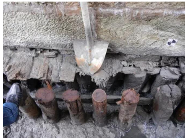
Figure 24 : Pieux en bois émergés lors de travaux
