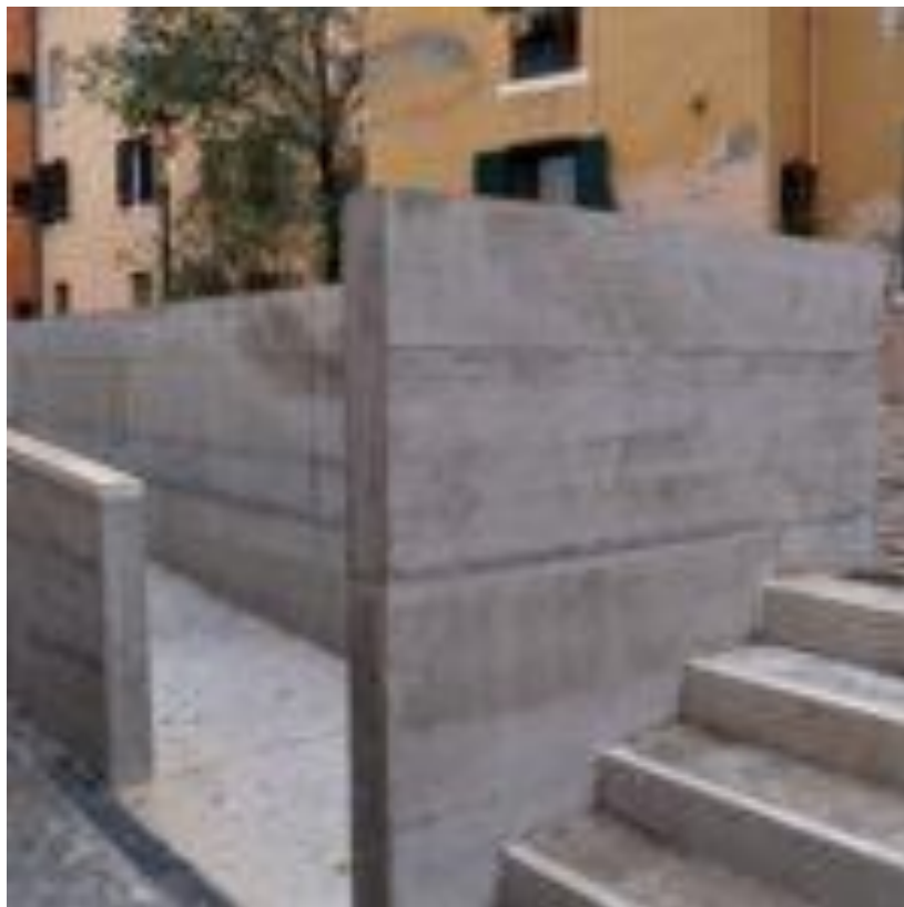
Figure 37 : Escaliers et pente extérieurs en béton armé
