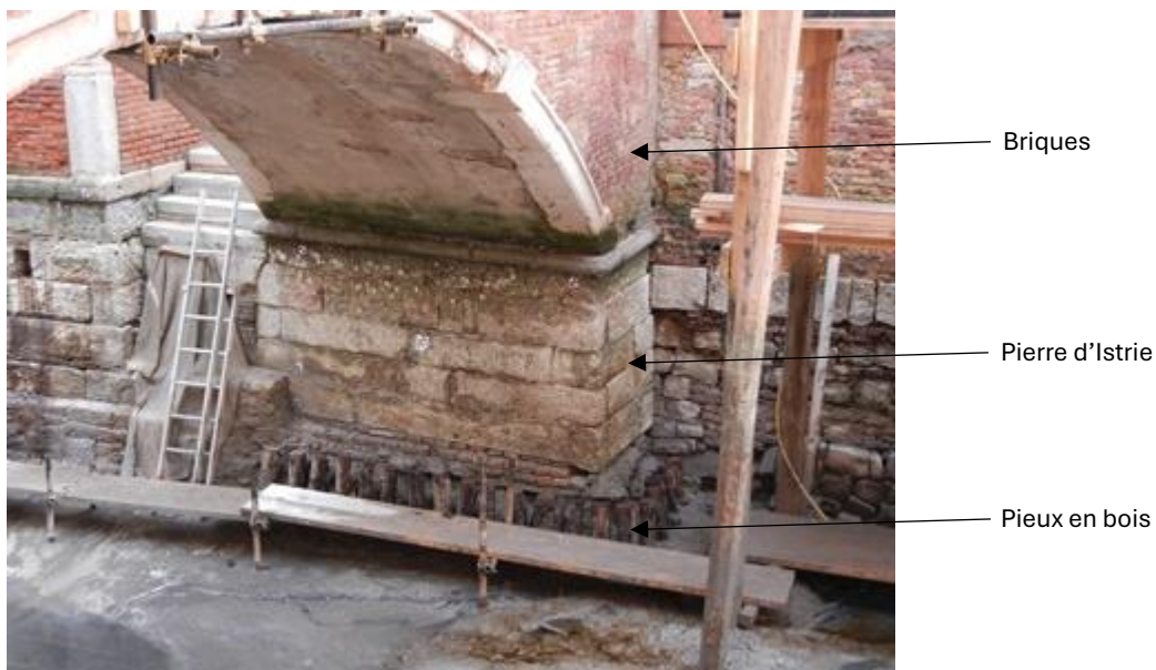
Figure 13 : Fondation d'un pont visible grâce à l'assèchement d'un canal
