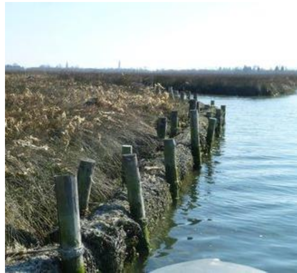
Figure 56 : Stabilisation des berges à l'aide de fagots de bois
