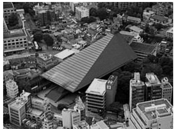
Figure-29 : Photo aérienne du Temple Shakaden Reiyukai, [Takenaka Corporation, 2006]
