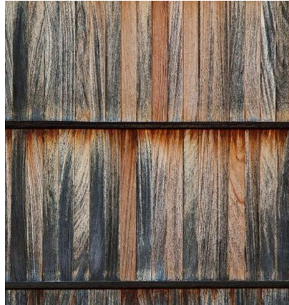
Figures 4 et 5 : Usure du teck Photographies non nommées https://www.mcilvain.com/the-salk-institute-teak-restoration-project/ https://theruleoftrois.tumblr.com/post/19403650812/inspiration-wood-detail-salk-institute-louis
