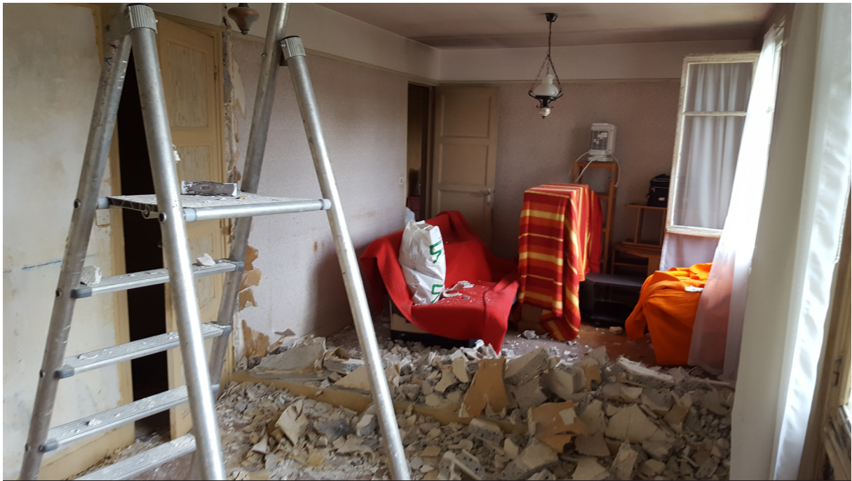
Démolition du mur entre Ch.1 et Ch.2. La cloison au fond sera également démolie.
