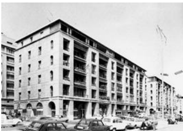
Figure 1: Immeuble quai de la mairie à Marseille par Fernand Pouillon (Source : http://archi.climatic.free.fr/0822.html )
