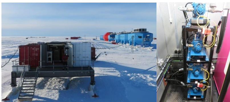
Ci dessus, le container extérieure contenant du matériel de mesure scientifique ainsi que les turbines C30. Certains des modules de Halley VI possèdent leurs propres turbines C30 en cas d'avarie.
