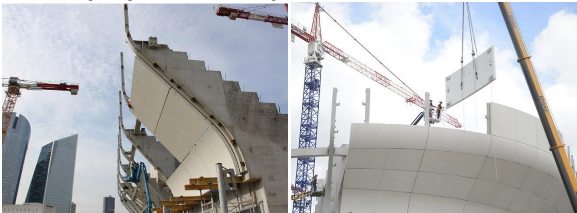
Figure 32et 33 : La mise en place des coques en béton préfabriquées de l'aréna 92
