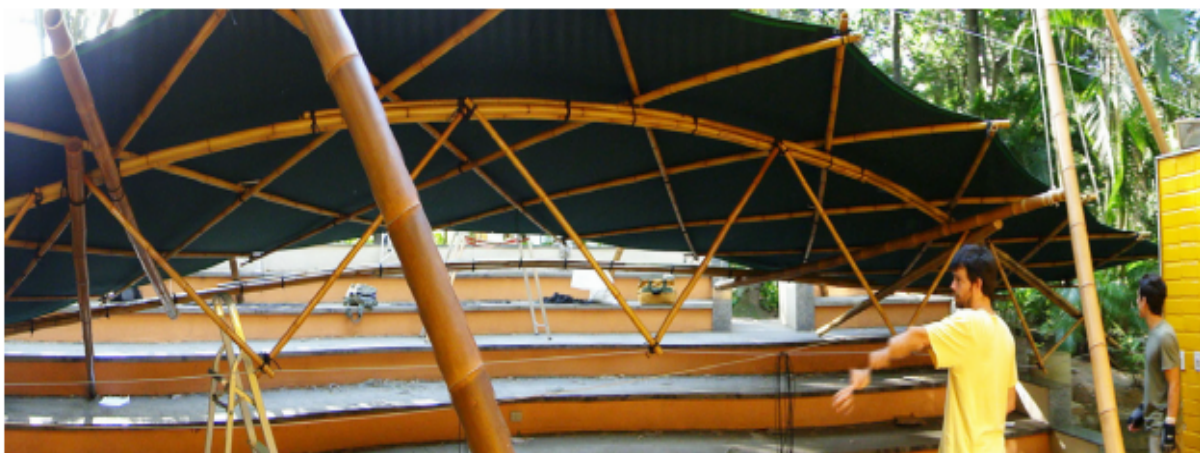
Figure 30. Couplage de poutres actives en flexion sur la première grille pantographique de traction suspendue. Source: Bambutec.
