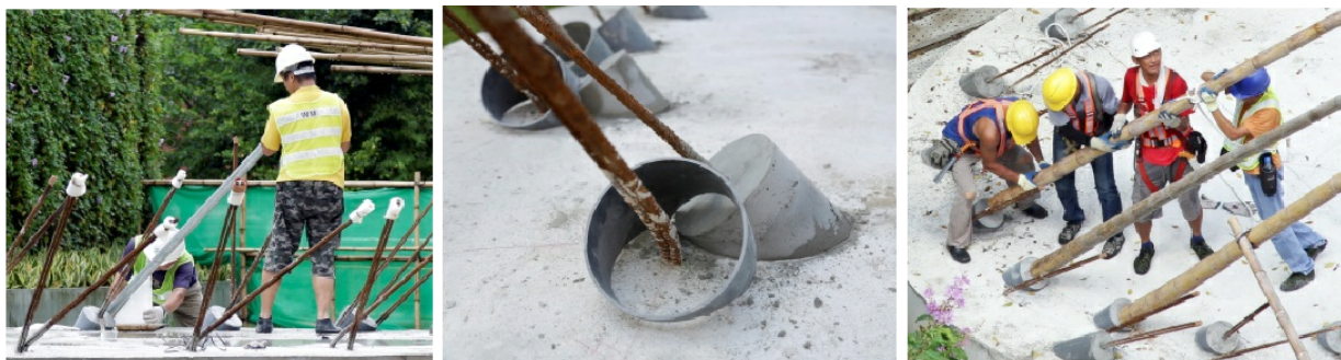
Figure 19. Raccordement à la fondation: cintrage manuel de la barre pour corriger l'angle à l'aide d'un tuyau en acier (Gau- che); socles de fondation de poteaux individuels coulés dans des tuyaux de drainage en PVC coupés à la main (au centre); positionnement du bambou sur les barres d'armature (à droite)
