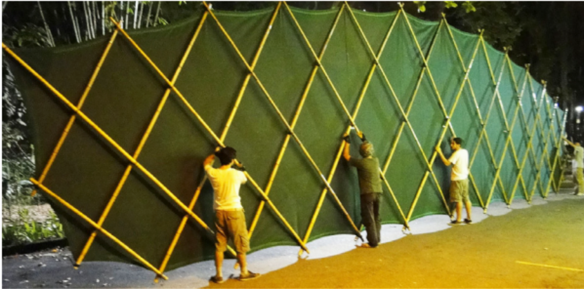
Figure 29. Grille pantographique en traction Source: Bambutec.
