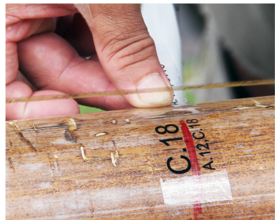
Figure 41. (Gauche) Coordonnées du point d'intersection des pôles, (Droit) Étiquettes autocollantes avec les informations de connexion
