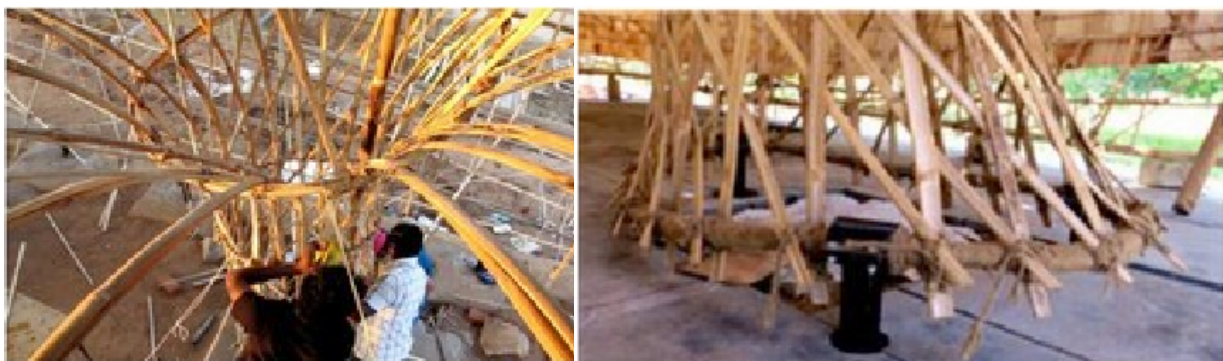
Figure 36. Construction du poteaux central et Anneau tissé pour la base Source: L. H. Hansen et S. Kim
