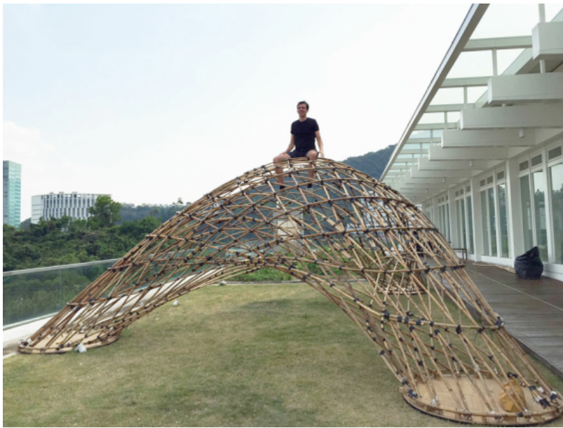
Figure 17. Deuxième prototype, utilisé pour l'évaluation du comportement structurel. Source: Kristof Criolla
