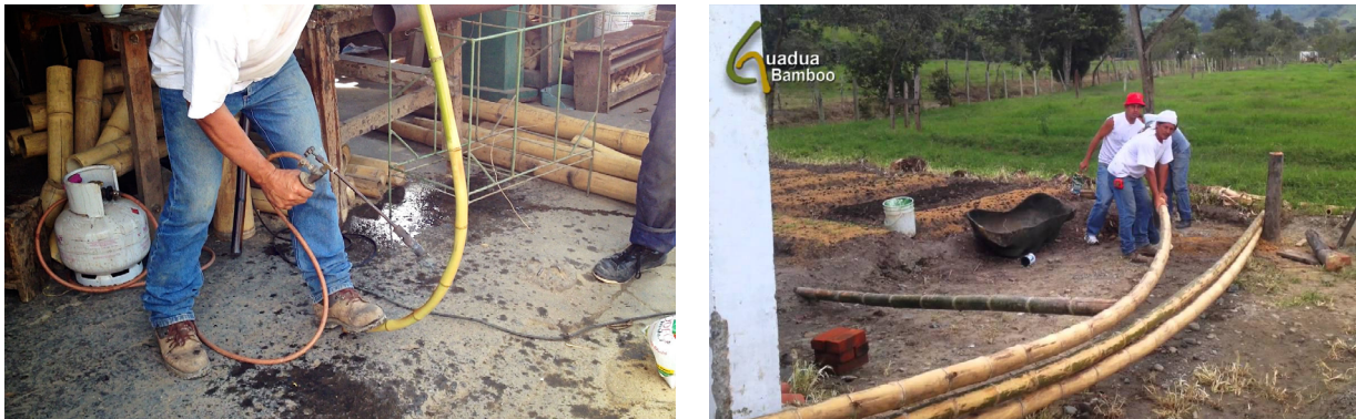
Figure 6. Méthodes de flexion à chaud (gauche) et Méthodes de flexion à froid (droit) Source: How to bend bamboo, Stéphane Schröder, (2013)
