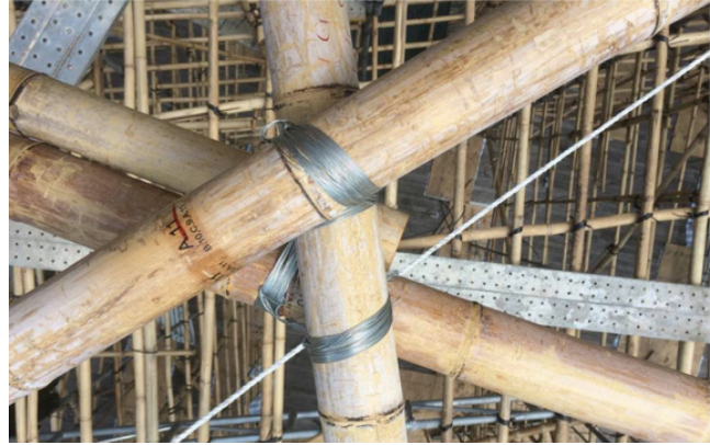
Figure 20. Exemple typique de décalage entre les articulations Source: Kristof Criolla
