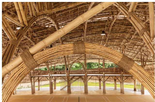
Figure 7. Tiges Courbes et Assemblées Source: Alberto Cusi (Archydaily)
